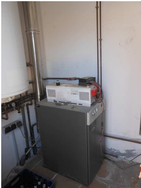
F. 1 Caldera de combustión estándar de gasoil para calefacción y producción de ACS
